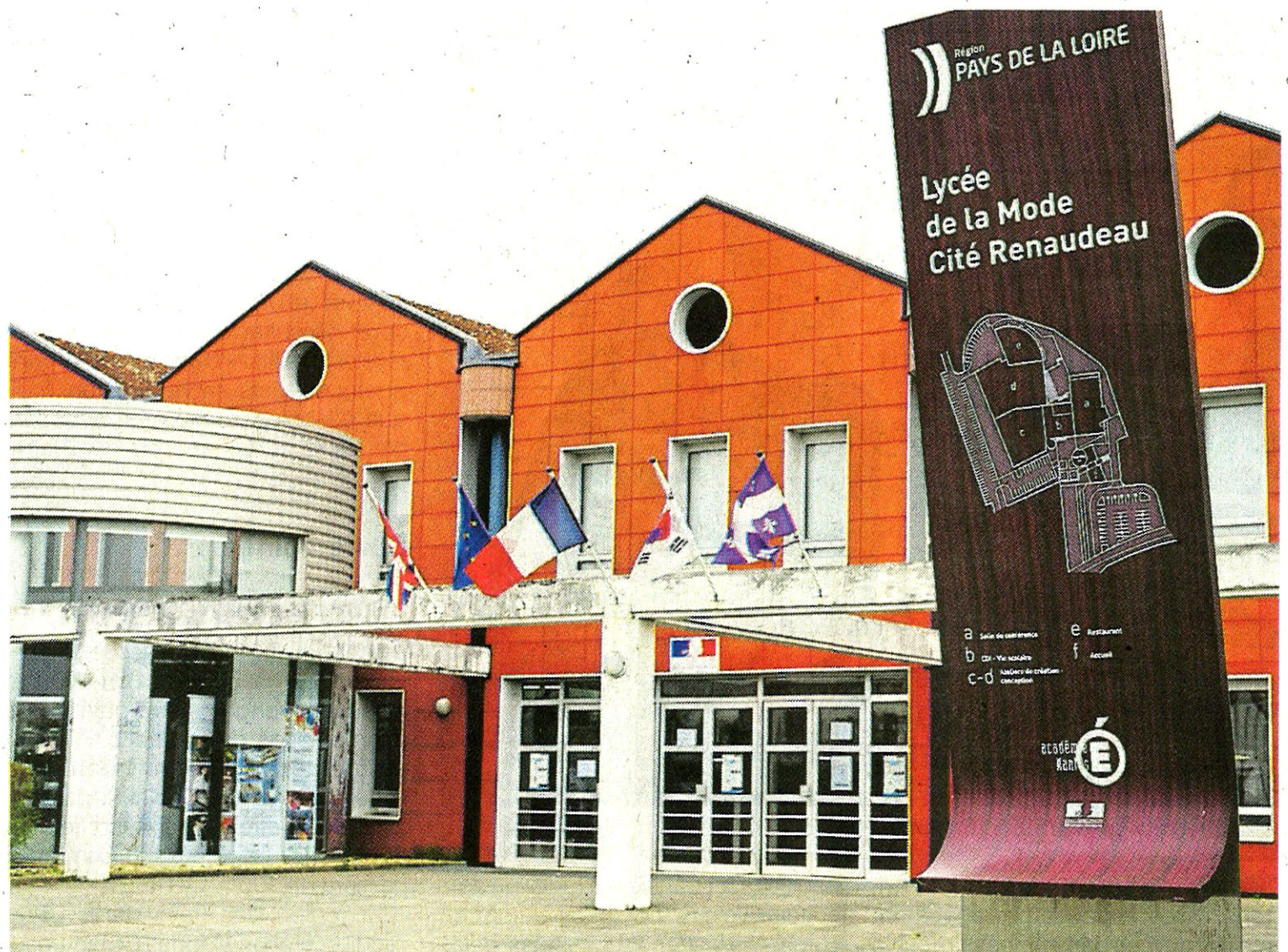
Au lycée de la Mode, à Cholet, la capacité d'origine de 400 élèves n'a pas changé depuis 32 ans, aucun chantier de grande ampleur n'ayant été réalisé pour l'agrandir.
